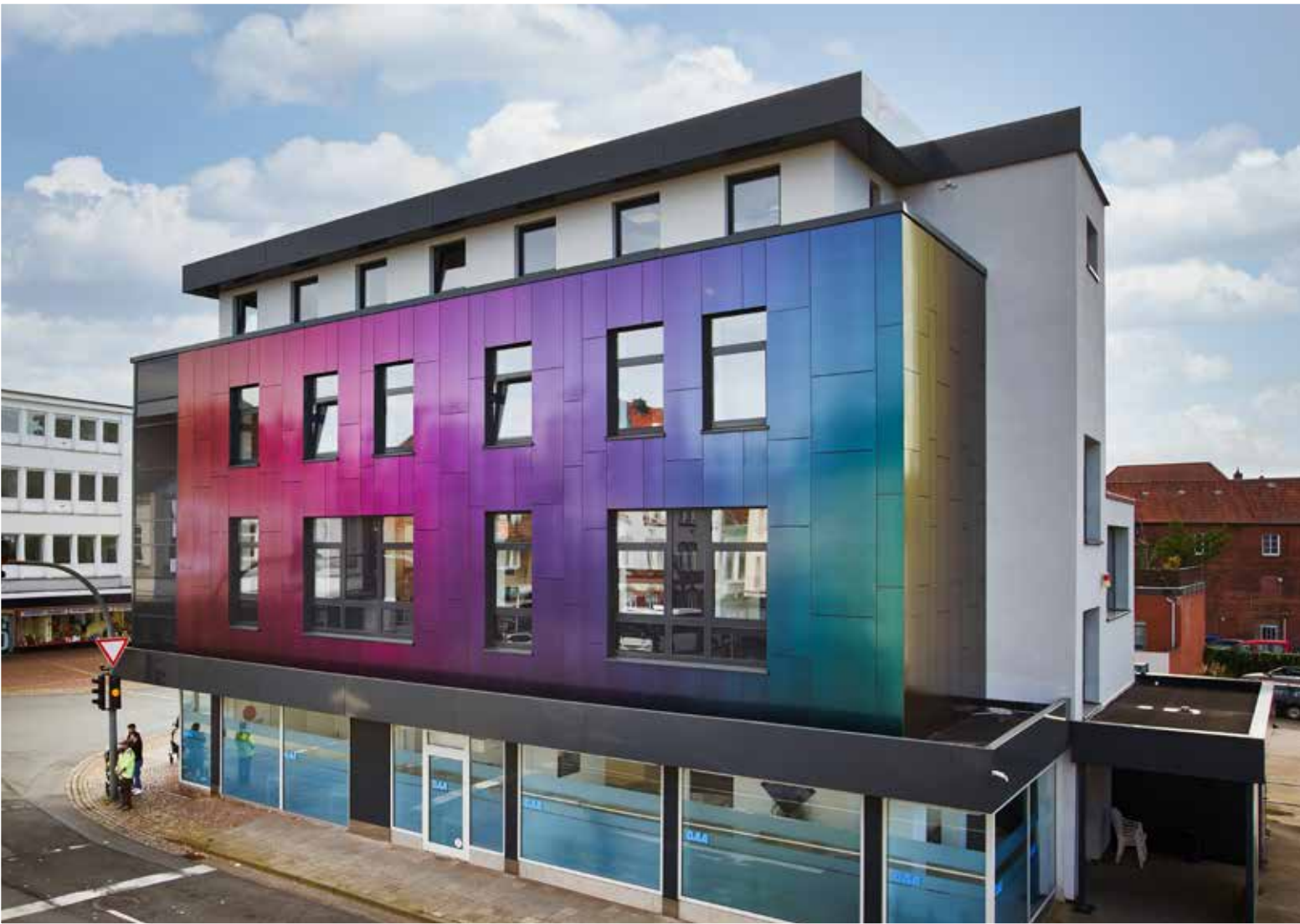
Project: Renovatie van kantoorgebouw, Nienburg, Duitsland
